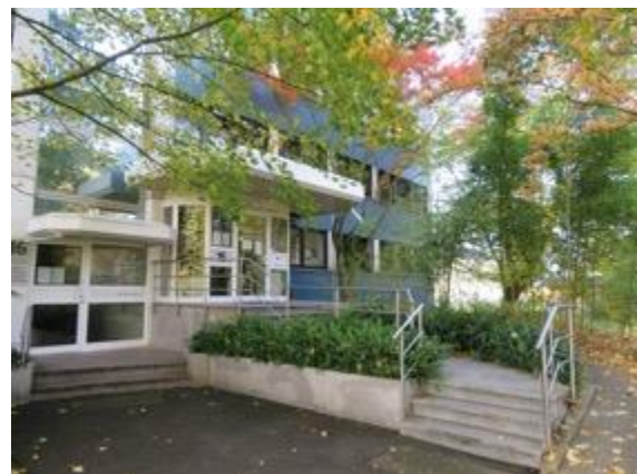
Ansicht: Nebengebäude / Praxis Dr. Corzilius
