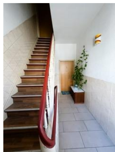
Ansicht: OG Treppenhaus
