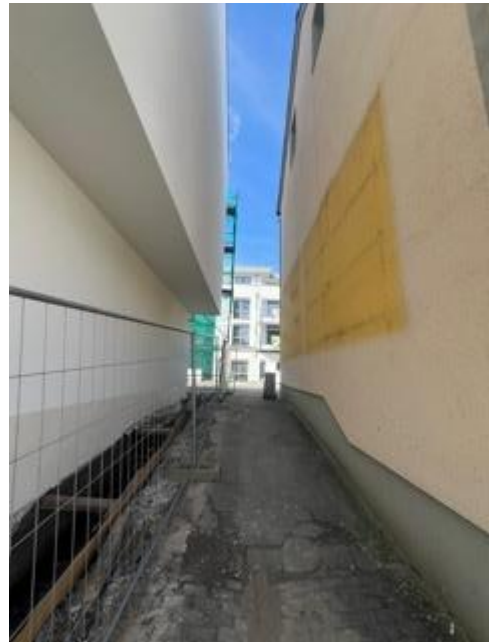
Ansicht: Seitenweg zum Innenhof
